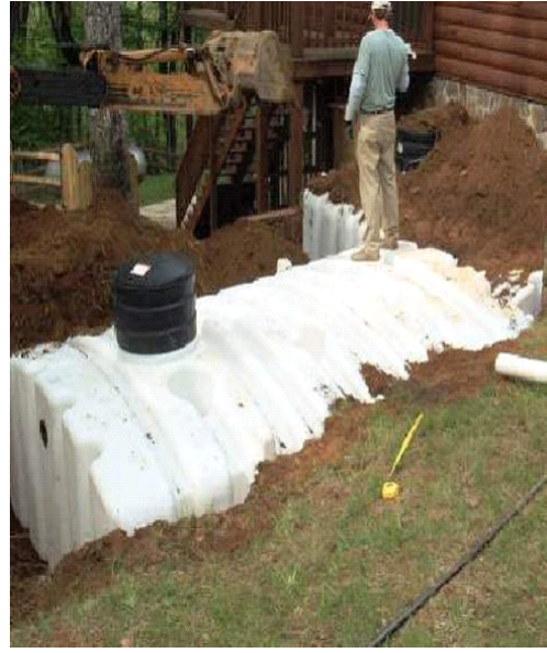
그림 18 Rainwater Harvesting 시공 현장
